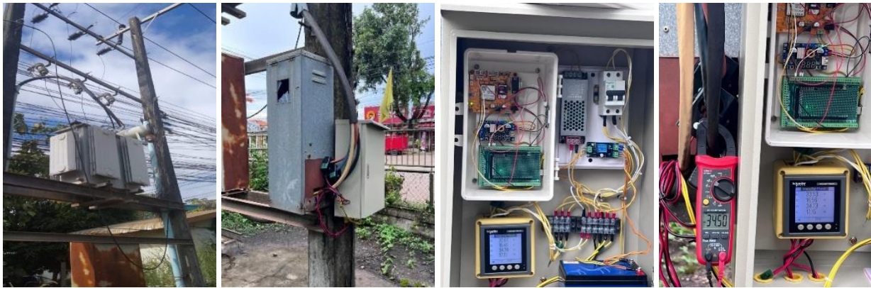
ຮູບທີ 3: ການຕິດຕັ້ງລະບົບວັດແທກໃສ່ໝໍ້ແປງຈຳໜ່າຍ 22/0.4 kV
